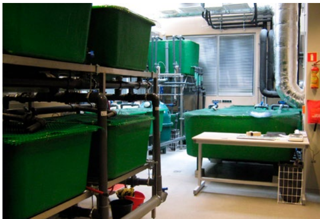
Fotografia 4. Zamknięty obieg recyrkulacyjny, w głębi widoczny górny zbiornik retencyjny oraz wydajny system filtracji (foto: T.K. Czarkowski)
