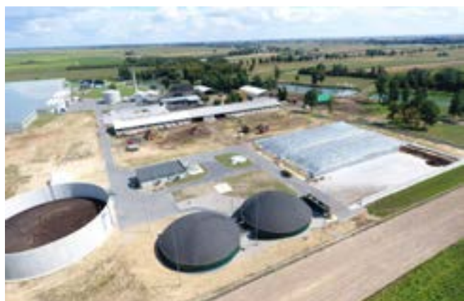
Widok ogólny na biogazownię, w głębi obora i szklarnie
