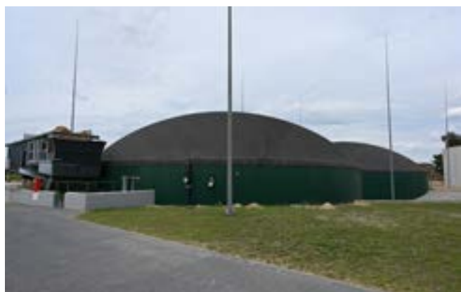
Kosz zasypowy (z lewej) przy fermentorze biogazowni, w głębi dofermentor
